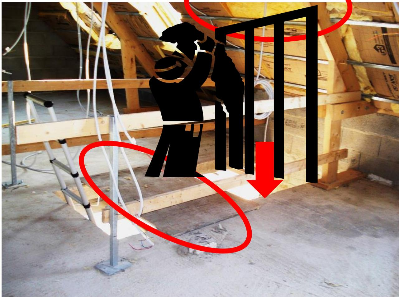
Les garde-corps (non conformes) ceinturant cette trémie ne permettent pas la pose de l'**isolation** en sécurité. Le platelage de fortune qui est ajouté représente un grand danger (résistance, risque de glissement)
