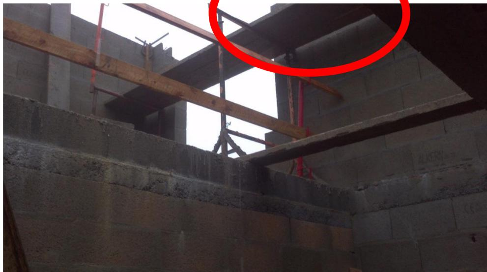
Les garde-corps (incomplets) ceinturant cette trémie ne permettent pas la réalisation des travaux de **maçonnerie** du pignon en sécurité.
