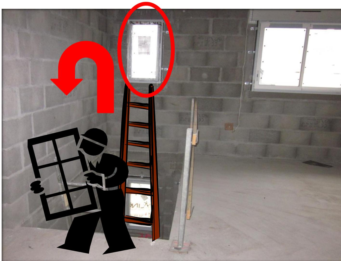
Les garde-corps (non conformes) ceinturant cette trémie ne permettent pas la pose de cette **menuiserie** en sécurité.
