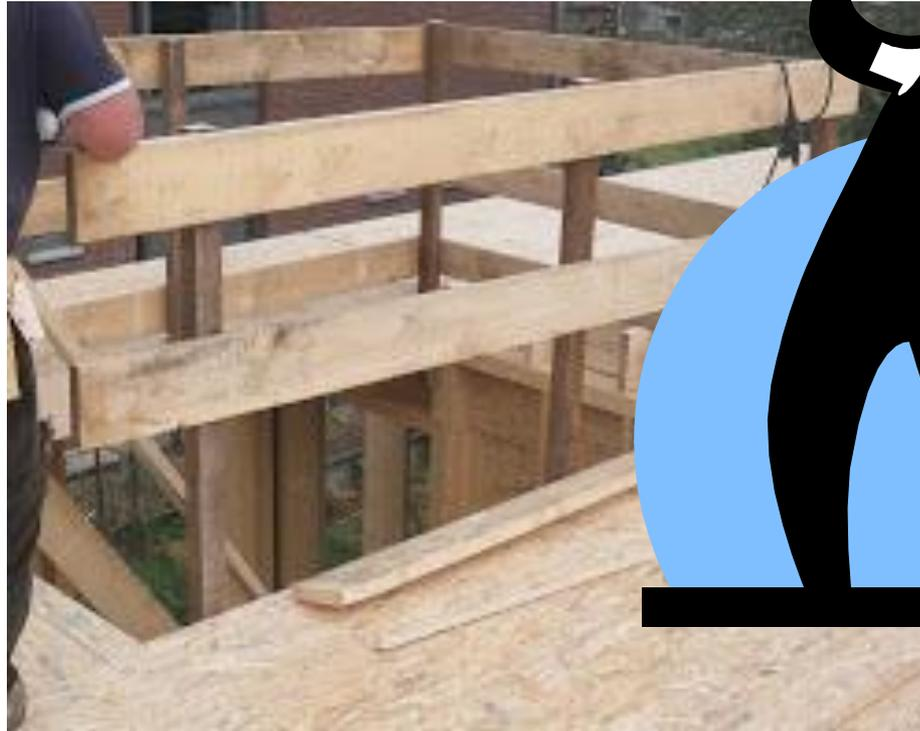
Un garde-corps est constitué d'une lisse à une hauteur comprise entre 1 m et 1,10 m, d'une plinthe d'une hauteur comprise entre 10 et 15 cm (en cours d'assemblage sur cette photo) et d'une sous lisse à mi-hauteur.
