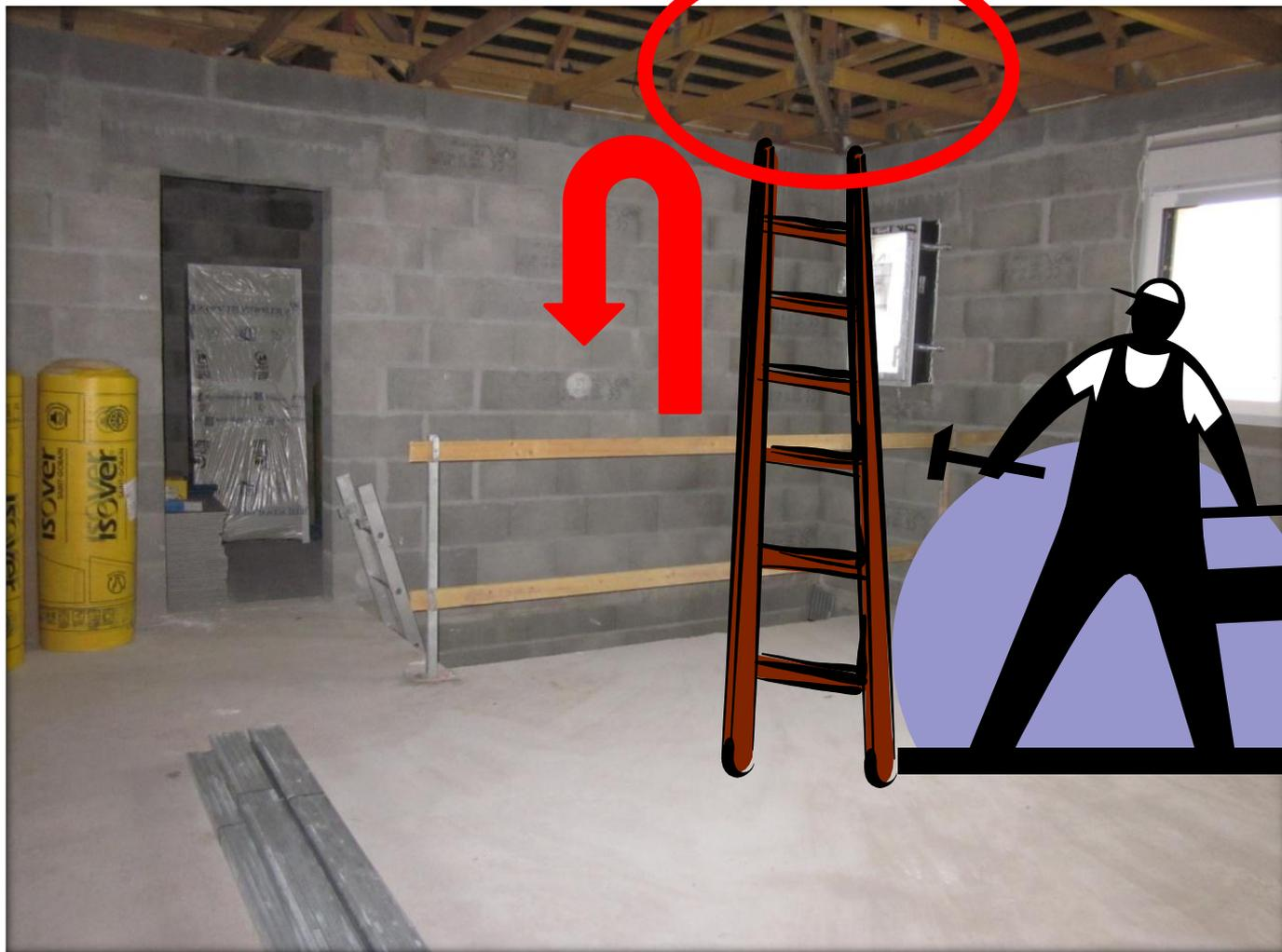
Les garde-corps (non conformes) ceinturant cette trémie ne permettent pas la pose de cette portion de **charpente** par l'intérieur en sécurité.
